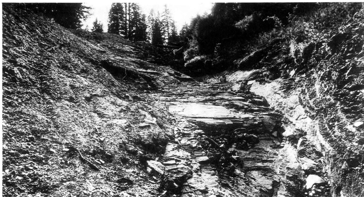
Eroze v murové dráze ze 4. 7. 1991
