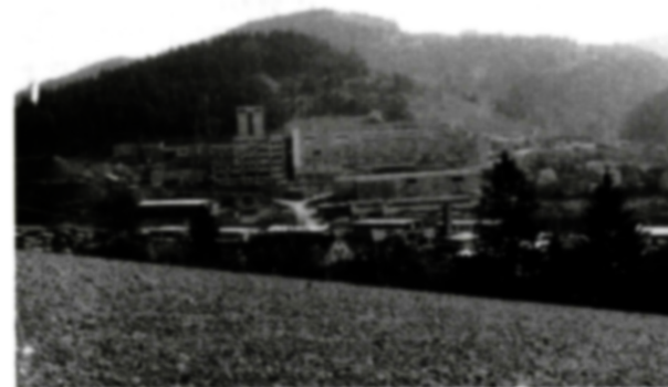
Údolí Svratky ve Švažci počas výstavby úpravní vody VOV
