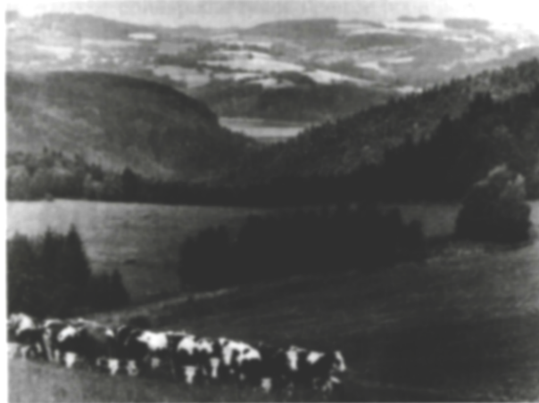
Údolí Svratky ve Švažci před výstavbou úpravní vody Vírského oblastního vodovodu (VOV)
