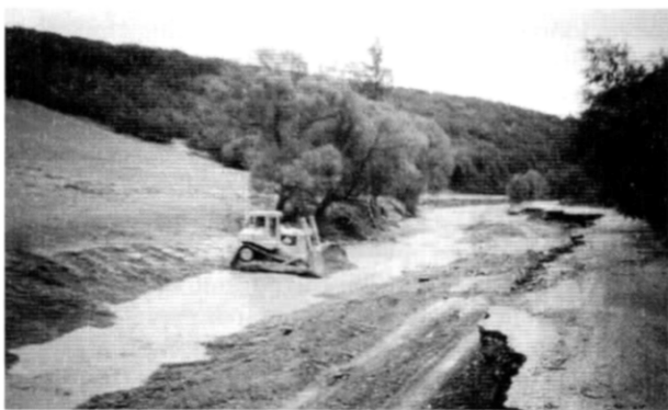
Robí sa nové koryto Svinky. Povodeň r. 1998. Foto: J. Lichý.
