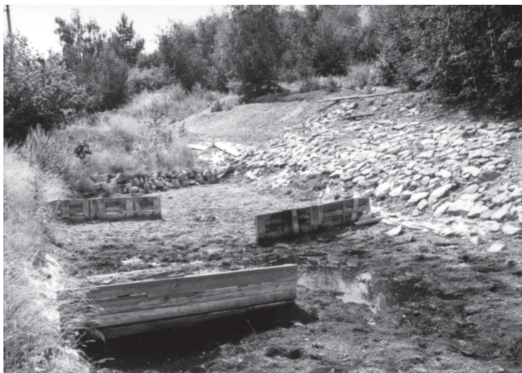
3. Biologická čistiareň kyslých banských vôd z lomu a haldy pod Šobovom. Foto: E. Kočická
