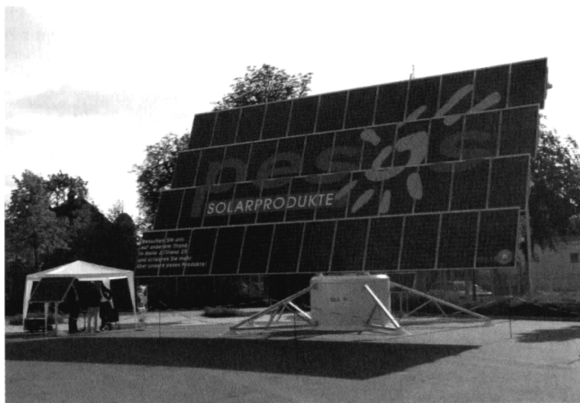
Dvojosový sledovací fotovoltaický systém. Foto: M. Šúri
