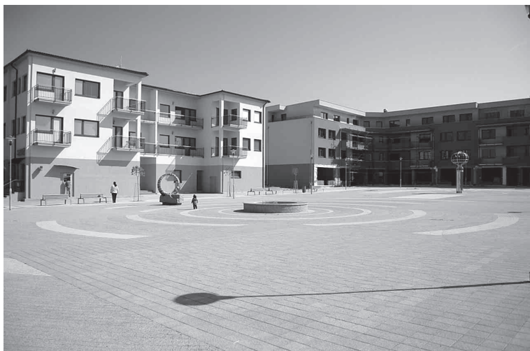
Nevhodne riešené verejné priestranstvo bez vegetácie (nová výstavba v bratislavskej mestskej časti Lamač). Foto: archív autorky
