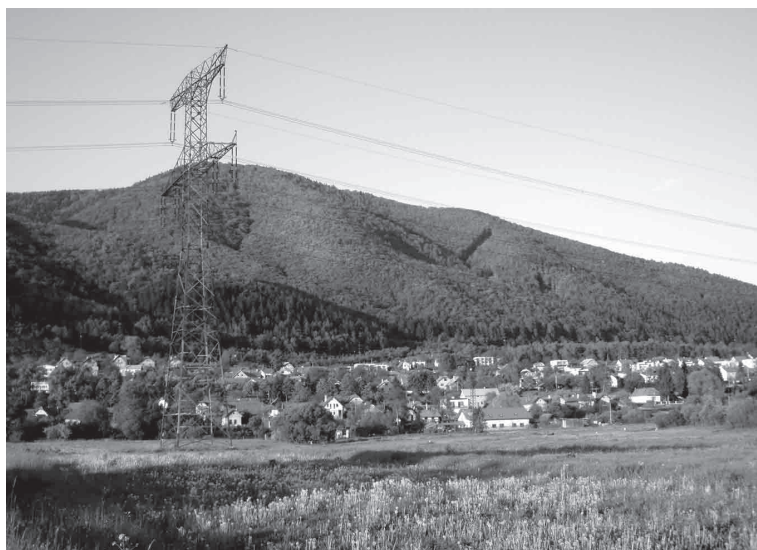
Nosný stožiar 2 x 400 kV vedenia, pohľad na obec Lipovec. Foto: M. Koošová, 2008
