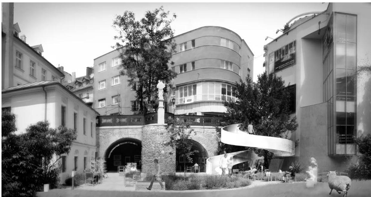
Obr. 2. Schody do Letnej čítárne Červený rak: návrh na sprístupnenie Letnej čítárne v Michalskej priekope pomocou schodov priamo z mosta. Z projektu Mestské zásahy . R. Buzinkay, A. Ferencík, J. Viskupič, 2008.
