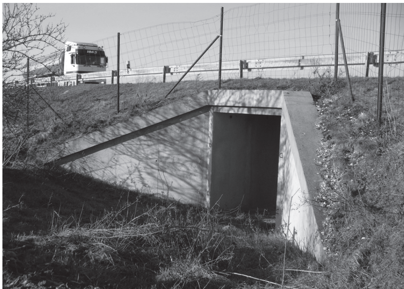
Obr. 1. Jednoduchý ekotunel pre stredne veľké živočíchy popod diaľnicu v Rusovciach Foto: J. Ružičková, 2008
