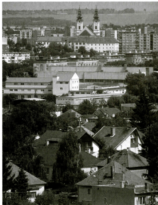
Obr. 5. Architektonická, funkčná, dobová a hodnotová heterogenita prvkov zastavanej časti sídla. Foto: V. Vanková, 2010
