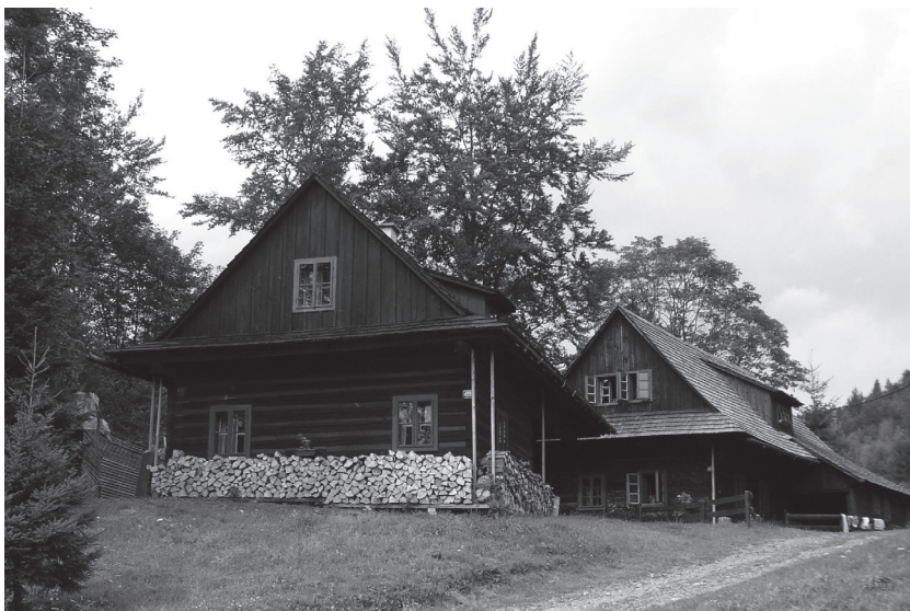
Obr. 2. Zachovaná lidová architektura Valašska. Citlivě rekonstruované stavby jsou využívány pro rodinnou rekreaci (Karolinka – Bzové, okres Vsetín, 2010). Foto: Alena Salašová
