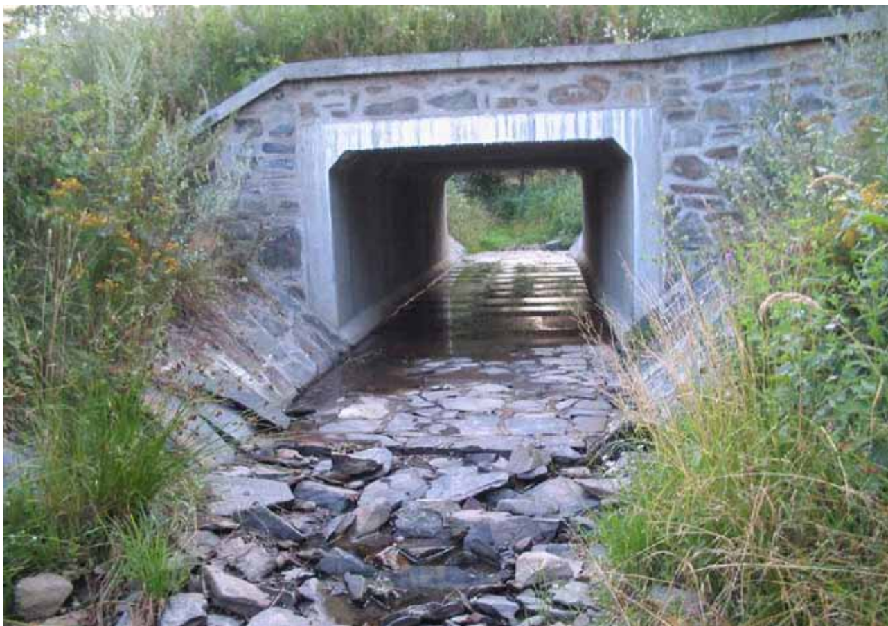
Obr. 1. Propust na Tetřevském potoce, kde je situován závěrový profil (2007). Foto: Antonín Hartmann
