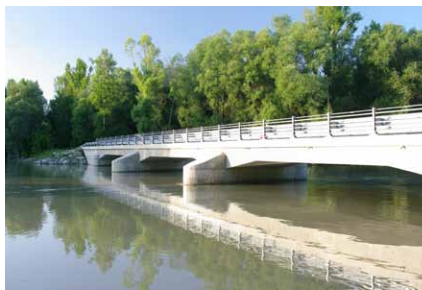
Obr. 2. Most ponad koryto Veľkolélskeho ramena nahradil po jeho sprietočnení cestu, križujúcu rameno na sypanej hrádzi len s malými priepustmi (jún 2016). Foto: Archív BROZ
